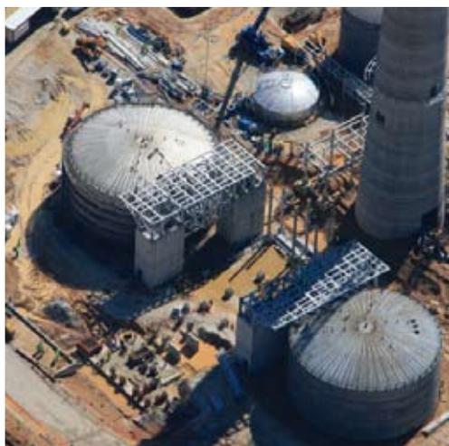
Tanques de sales fundidas en la planta Gemasolar
