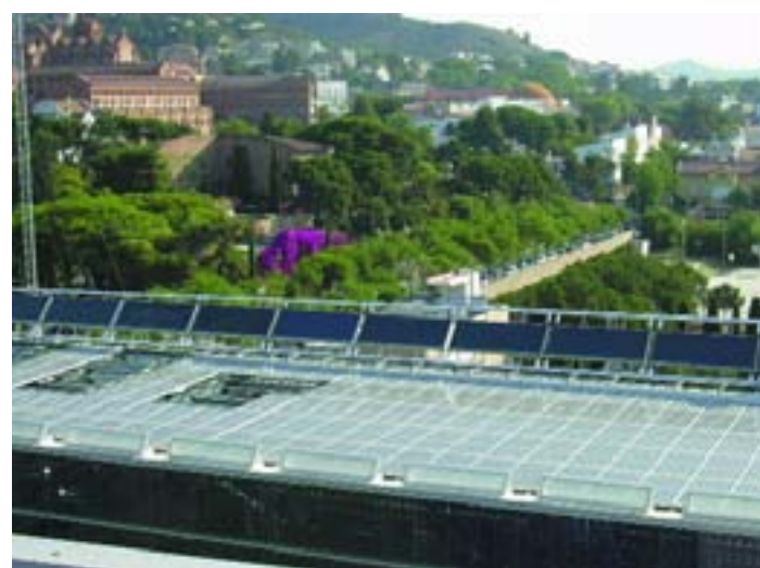
Escuela de Arquitectura e Ingeniería La Salle (Barcelona)
