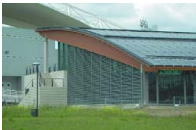
Cubierta solar en la Piscina Municipal de Haro (La Rioja)
