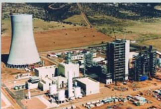
Central Gasificación Ciclo Combinado IGCC 335 MW ELCOGAS Puertollano (España)
