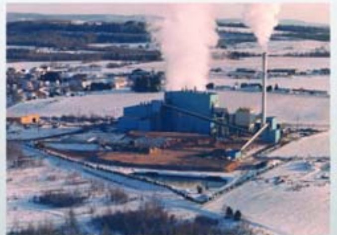
Central de Biomasa Fort Fairfield 35 MW, FAIRFIELD ENERGY VENTURE, Maine (Estados Unidos)
