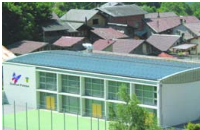
Cubierta solar en el Polideportivo de Varen (Suiza)
