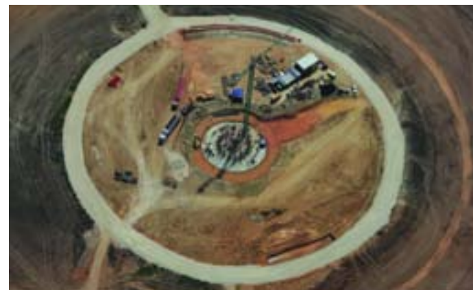
Avance de las obras de Gemasolar
